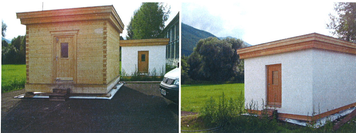
Bild 16: Blockbau und Riegelbau auf unterschiedlichem Untergrund, nach dem Verlegen der Folie
