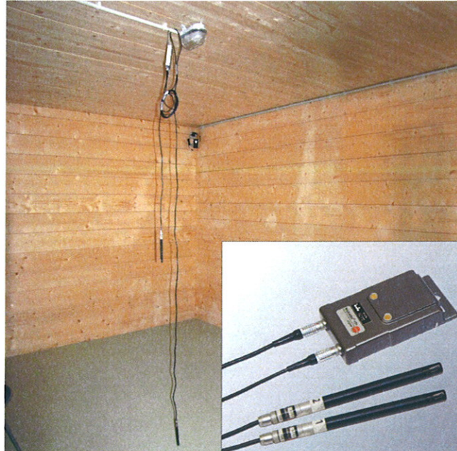
Bild 4: Messung des Innenraumklimas mit Testo 171
