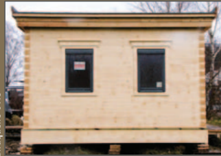
Gebäude mit Außenwänden in Massivblockbauweise
